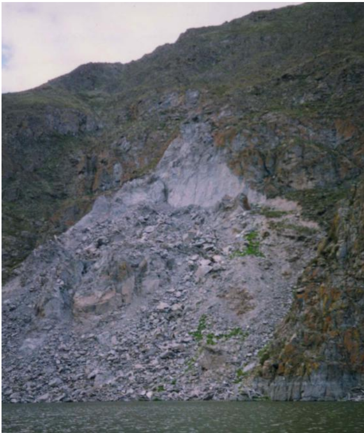
Фото 1. Оползни в приустьевой части р. Бол. Уры.
