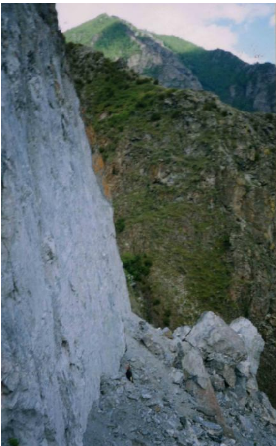
Фото 2. Оползни в приустьевой части р. Бол. Уры.
