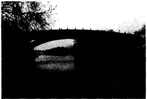
Мост Аньцицзяо (уезд Чжаосянь, пров. Хэбэй)
